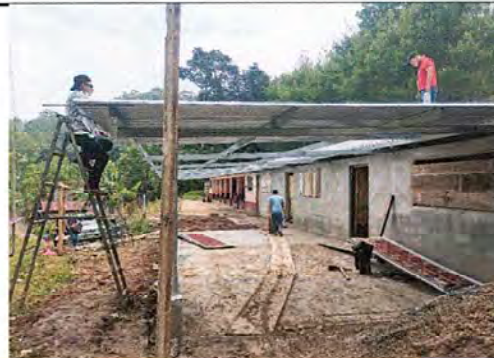
Foto 4: COLOCACIÓN DE LAMINAS
