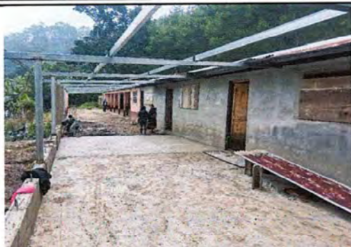
Foto1: AVANCE DE ENTORTADO DE CEMENTO Y REPELLO DE PARED DE MODULO 2
