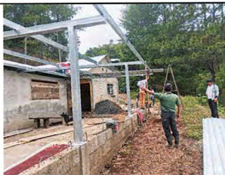
Foto 3: COLOCACIÓN DE LAMINAS
