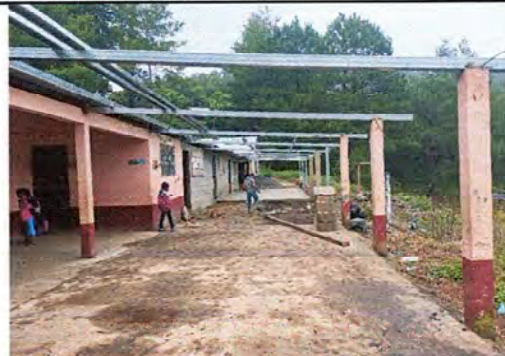
Foto 2: AVANCE DE ESTRUCTURA DE METAL.
