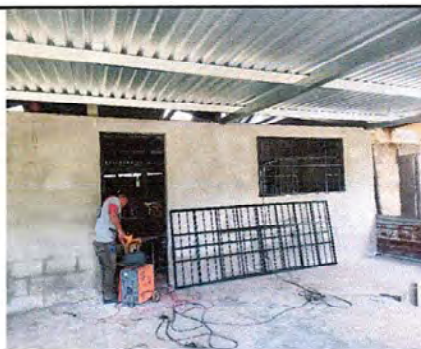
Foto 5: COLOCACIÓN DE VENTANAS Y PUERTAS DE MODULO 2
